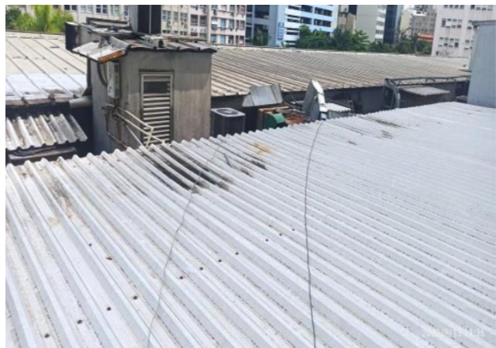
Coberturas – Local onde serão instaladas as placas fotovoltaicas
