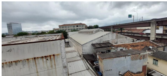
Coberturas – Local onde serão instaladas as placas fotovoltaicas
