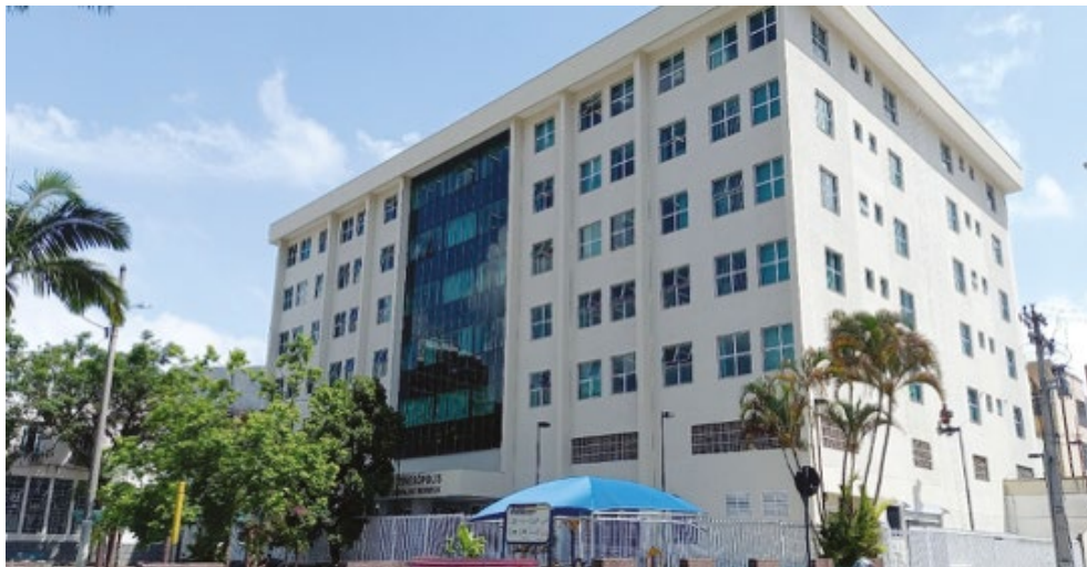
Fachada principal e lateral após a retirada dos granitos, com pintura e textura
