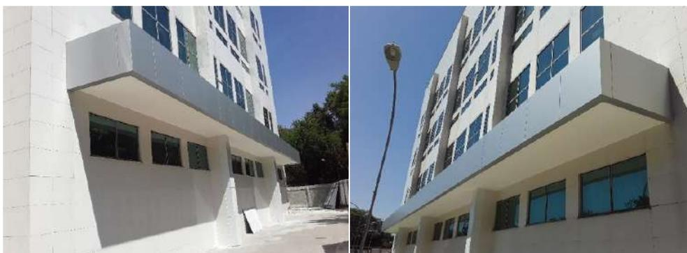
*Após demolição da marquise superior, reconstituição da marquise existente com acabamento em ACM e forro em gesso acartonado*
