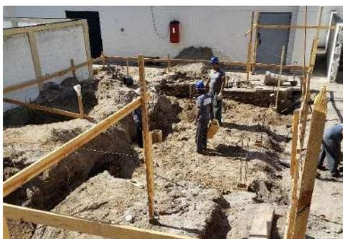
*Fundação da sala do operador, casa de bombas e sala de quadros*
