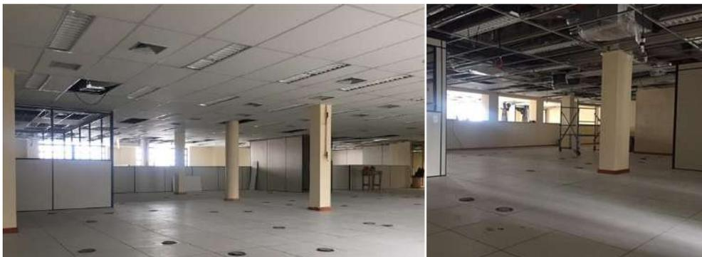
*Execução de forro removível em fibra mineral, piso elevado, instalações elétricas e especiais e sistema de climatização nas áreas novas*
