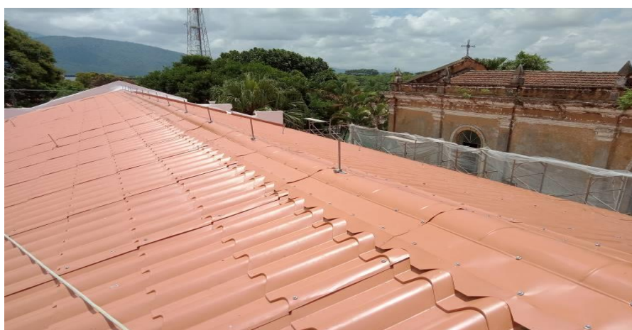
Telhas termoacústicas com instalação de SPDA
