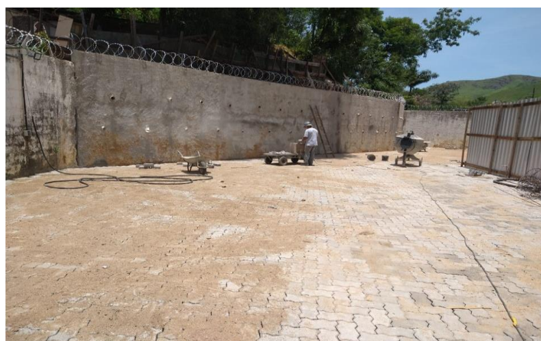
Assentamento de novo piso intertravado no pátio da carceragem
