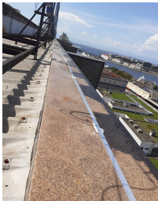
Visualização do subsistema de captação em barra chata de alumínio instalado para proteção contra descargas
