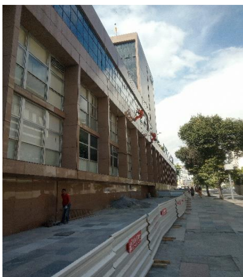
Utilização de mão de obra de alpinista na execução do subsistema de descida
