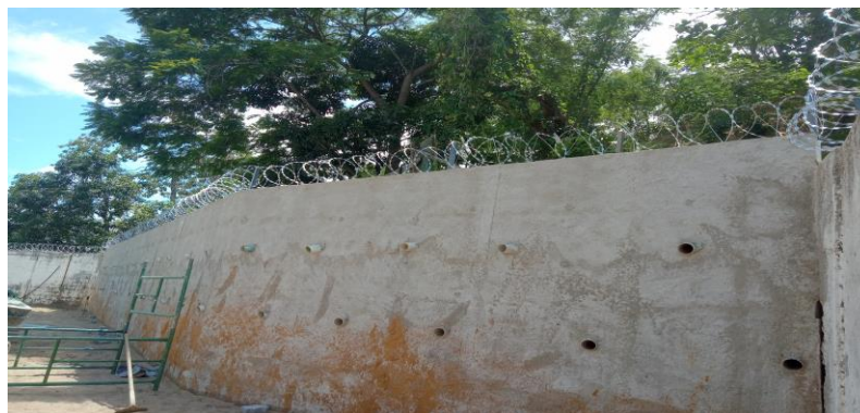
Construção do Muro de Contenção com instalação de concertinas
