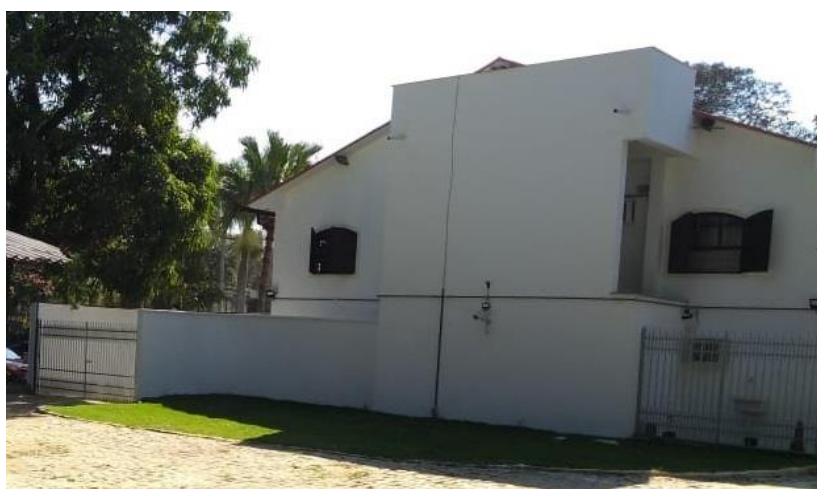
Fachada fundos com castelo d'água finalizado e entrada da carceragem
