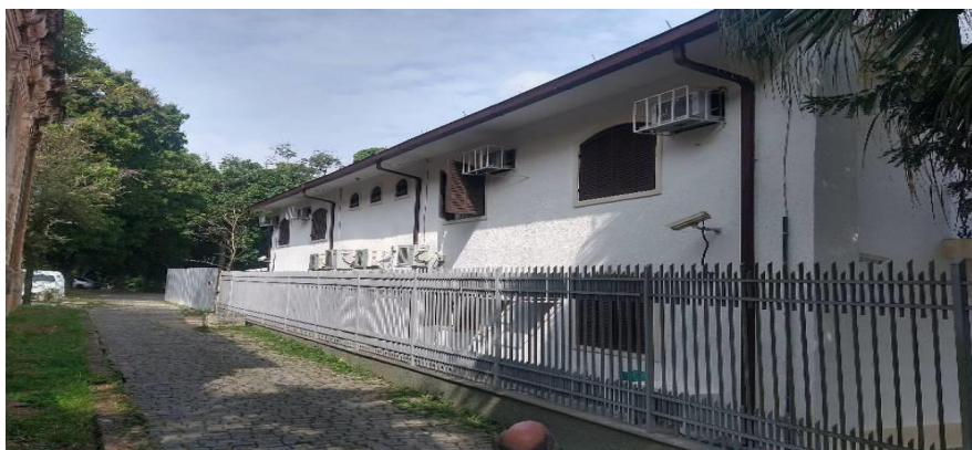
Pintura de fachada lateral, instalação de calhas e condutores de águas pluviais
