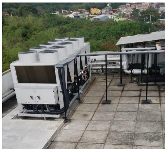
Chiller novo instalado e em funcionamento
