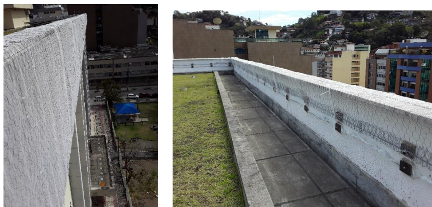
Proteção das platibandas na cobertura
