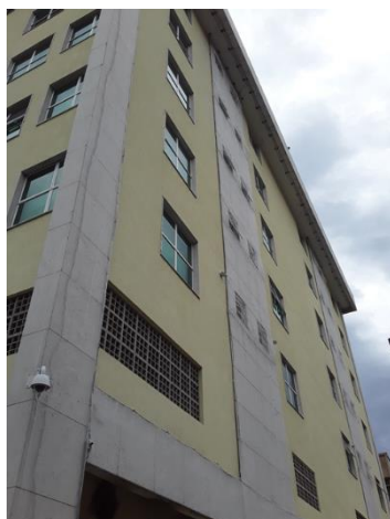
Proteção das fachadas com revestimento em granito
