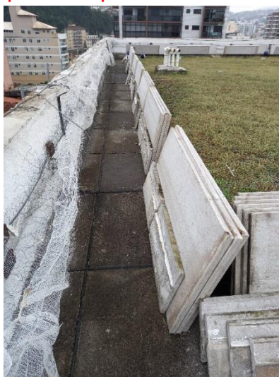
Granito retirado das platibandas e provisoriamente estocado na cobertura
