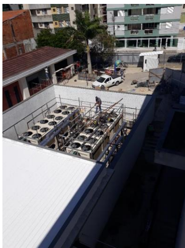
Novos Chillers instalados
