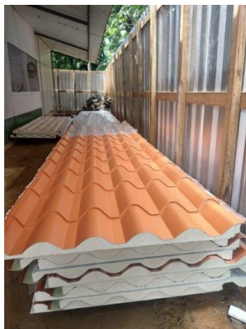
Telhas à serem instaladas na cobertura
