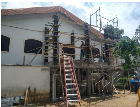
Execução do 2º pavimento do castelo d'água
