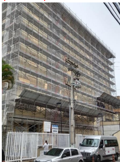
Fachada lateral com andaimes, tela, apara-lixo e proteção das esquadrias
