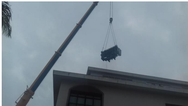
Içamento com guindaste para retirada dos equipamentos substituídos da cobertura
