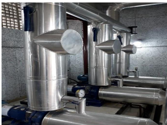
Bombas com isolamento na central e água gelada
