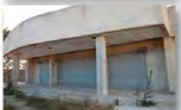
FÓRUM DA COMARCA DE ARRAIAL DO CABO
