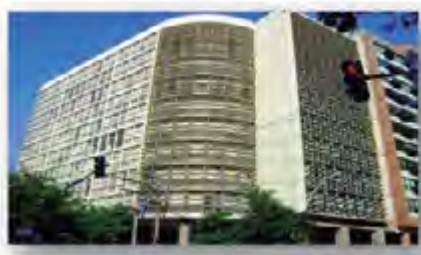
PRÉDIO DAS SECRETÁRIAS DA COMARCA DE NITERÓI
