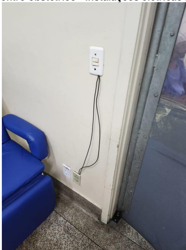
FOTO 42 – Centro obstétrico - instalações elétricas improvisadas
