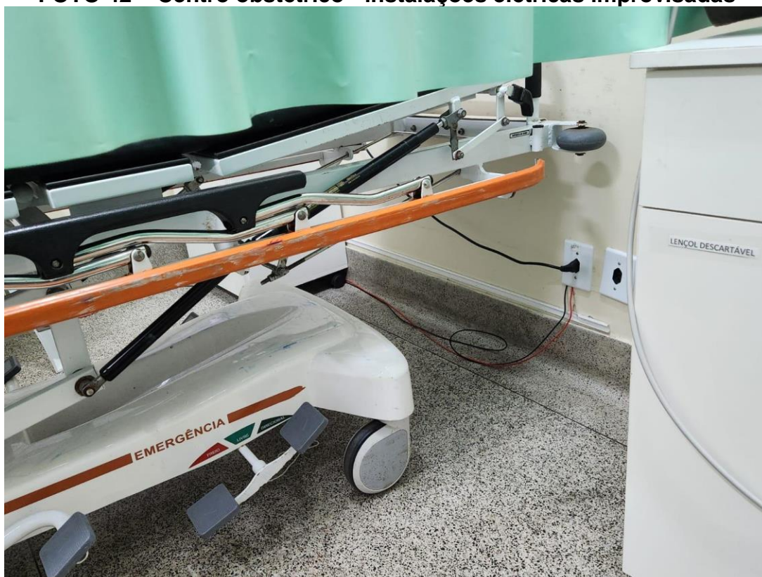
FOTO 42 – Centro obstétrico - instalações elétricas improvisadas
