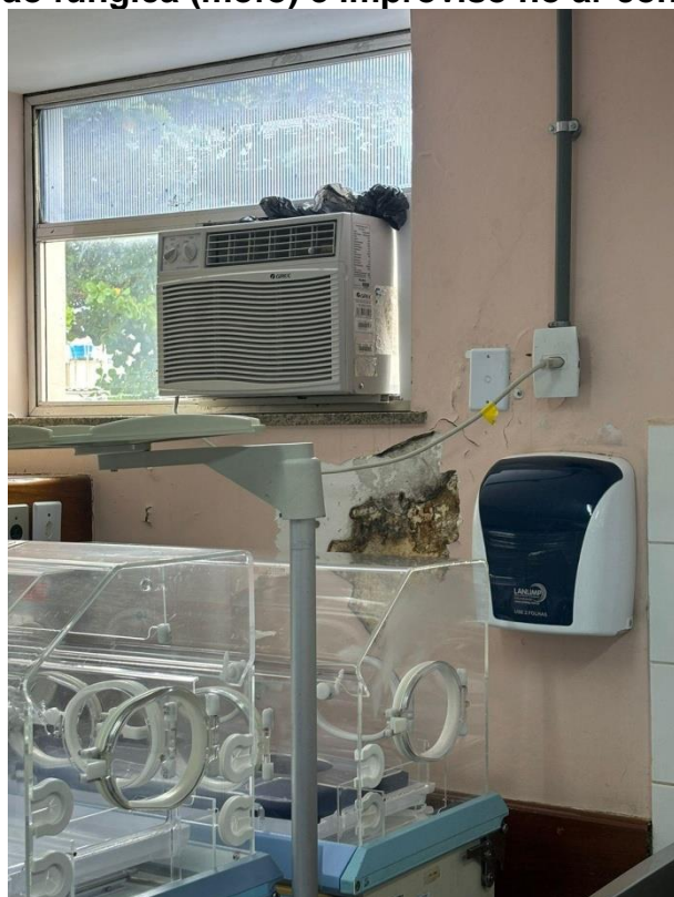
FOTO 56 – UI neonatal – más condições de conservação das instalações – colonização fúngica (mofo) e improviso no ar condicionado
