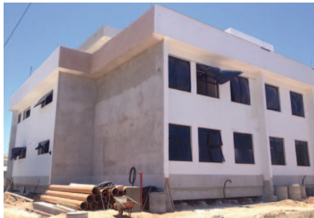
Construção do anexo do Fórum de Rio das Ostras
