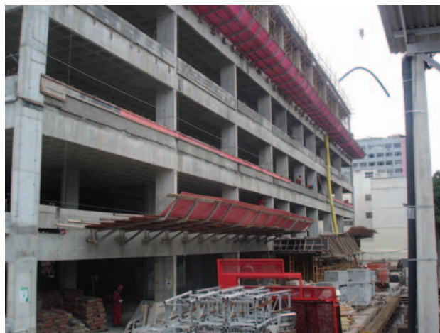
Antes: Fórum Regional da Leopoldina, em fase de construção
