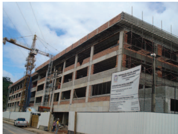
Encontra-se em andamento a construção do Fórum de Angra dos Reis
