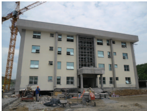
Obras do Fórum de Rio Bonito
