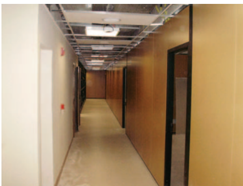
A reforma interna preservou os aspectos ainda originais da edificação
