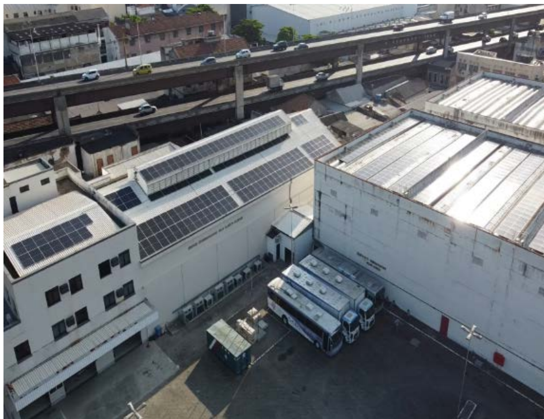
Placas fotos voltaicas instaladas
