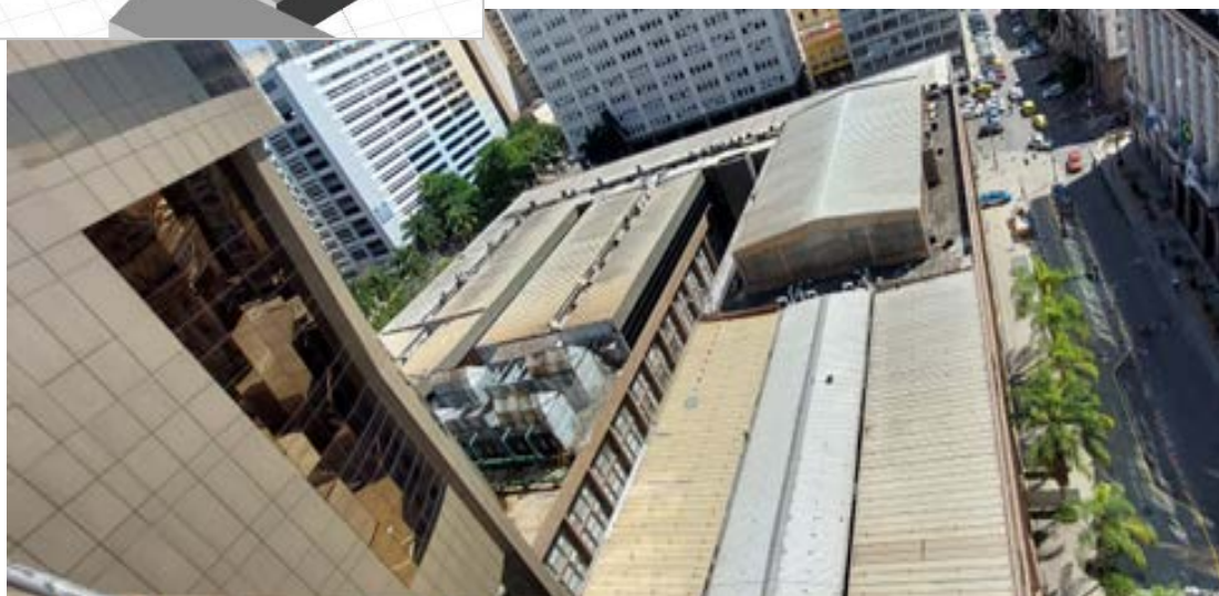
Cobertura - local onde serão instaladas as placas fotovoltaicas
