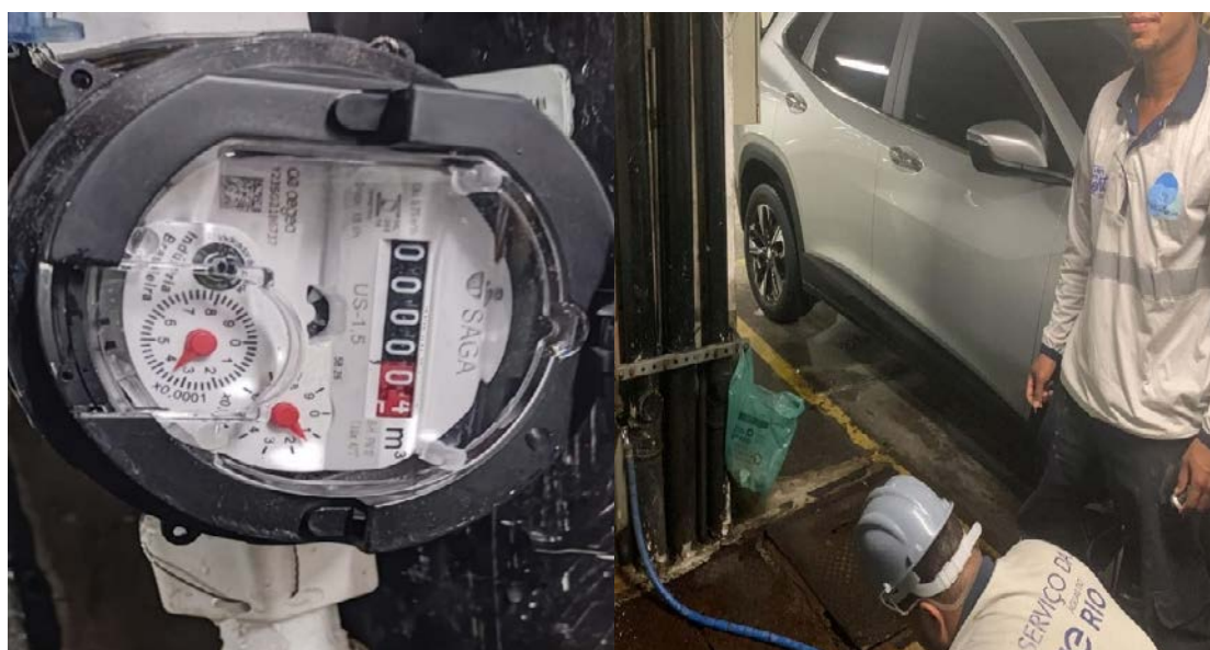
Instalação de hidrômetro
