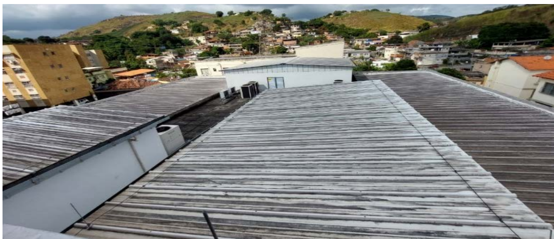
Cobertura - local onde serão instaladas as placas fotovoltaicas
