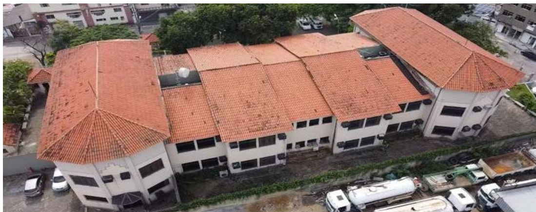
Cobertura - local onde serão instaladas as placas fotovoltaicas
