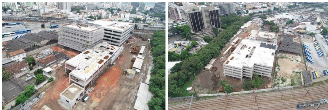
Vista aérea da construção do Projeto do NAI
