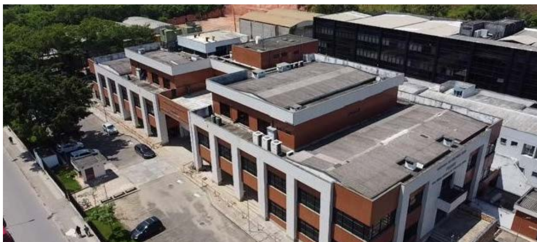
Cobertura - local onde serão instaladas as placas fotovoltaicas
