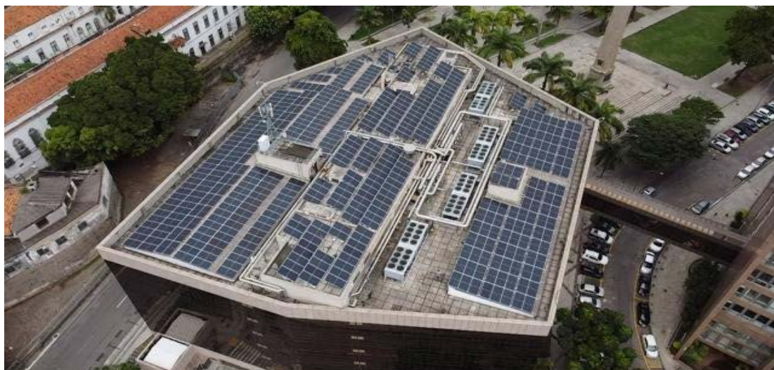
Placas fotovoltaicas instaladas
