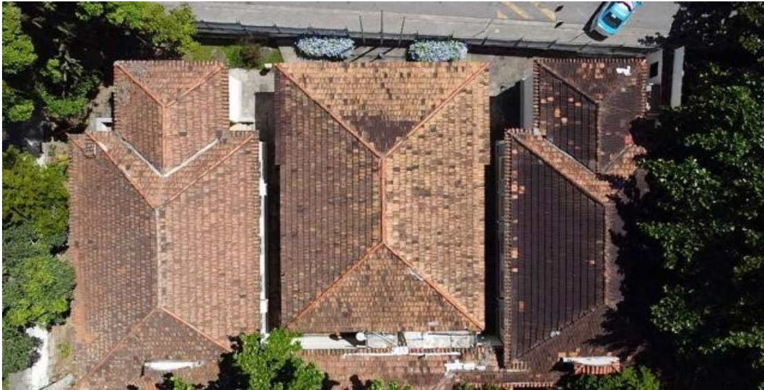
Cobertura - local onde serão instaladas as placas fotovoltaicas
