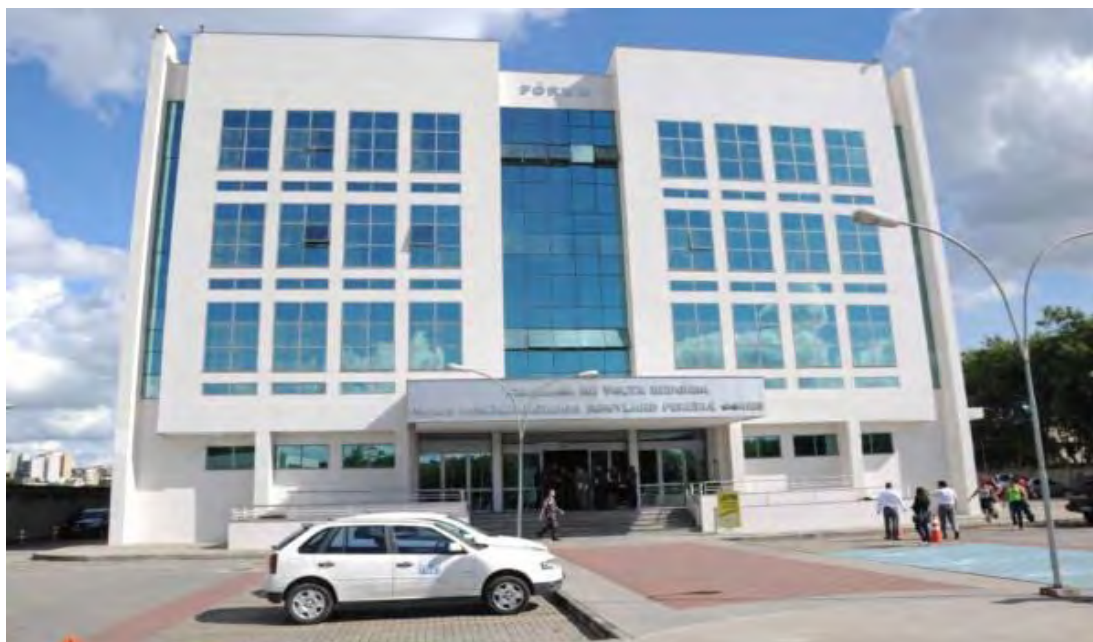
Fachada 1 - Rua Desembargador Ellis Hermydio Figueira
