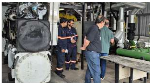
Visita técnica ao Fórum de Madureira, objetivando a melhoria dos indicadores de eficiência energética e hídrica.
