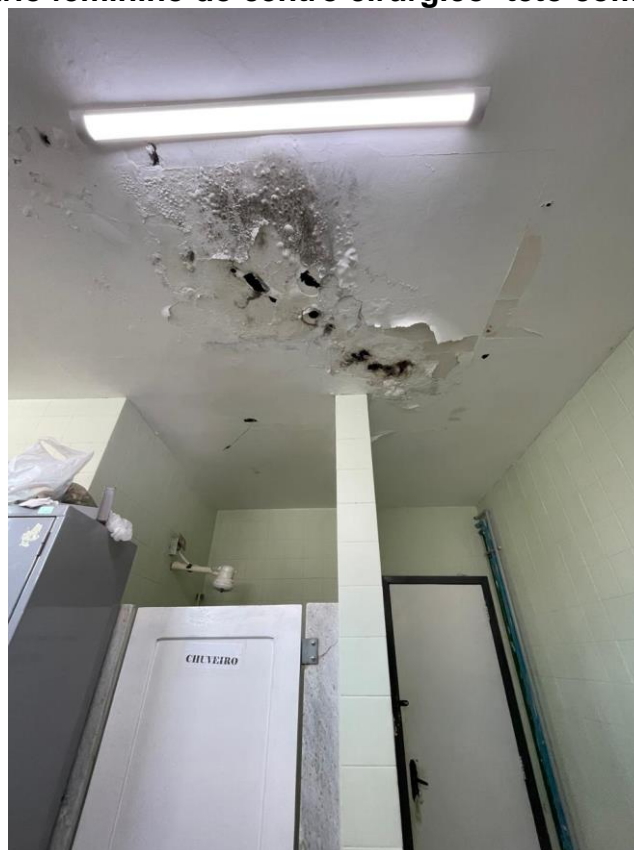
FOTO 54 – Vestiário feminino do centro cirúrgico- teto com mofo e infiltração
