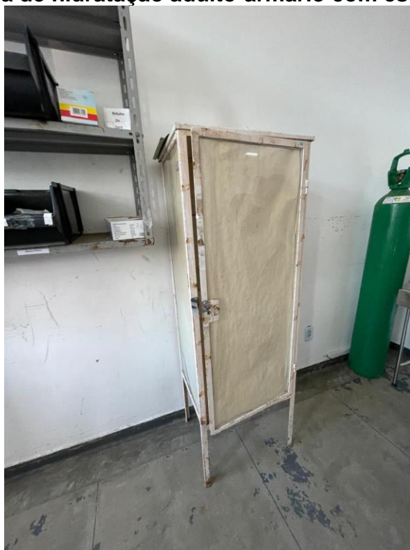
FOTO 34 – Sala de hidratação adulto-armário com estrutura oxidada
