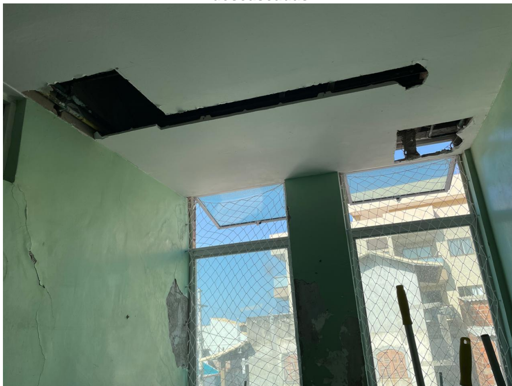
FOTO 99 – Clínica médica – corredor - teto com buraco, paredes infiltradas e descascadas
