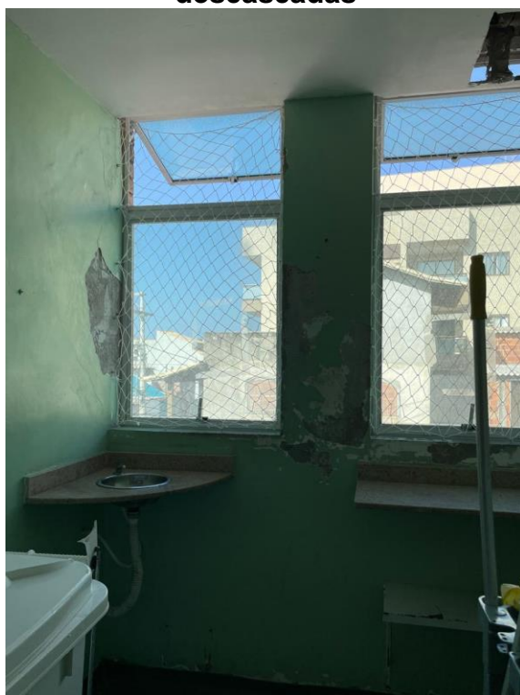
FOTO 98 – Clínica médica – corredor - buraco no teto e paredes infiltradas e descascadas
