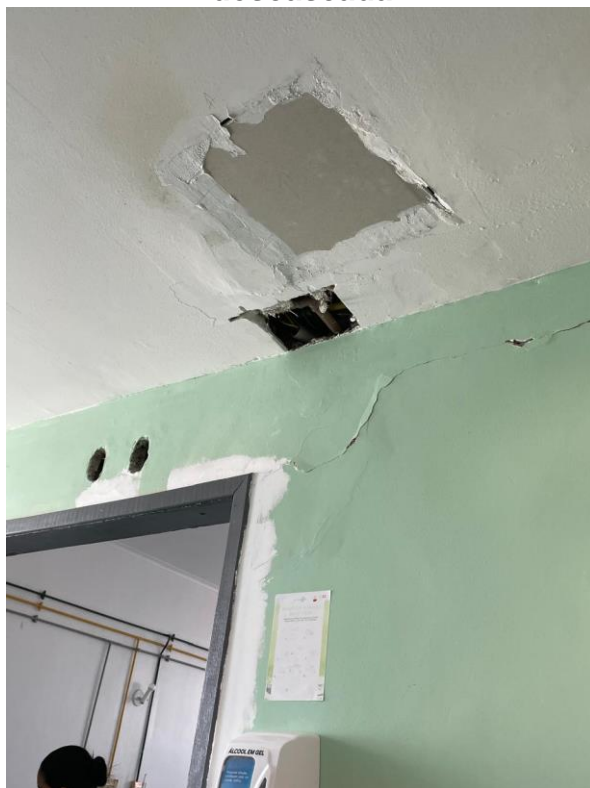
FOTO 97 – Clínica medica-corredor-teto com buraco, parede rachada e pintura descascada
