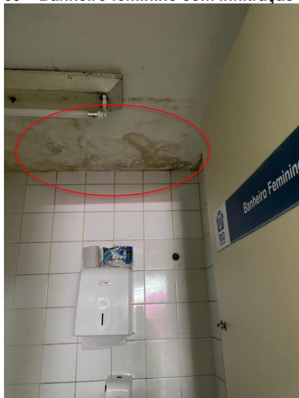
FOTO 60 – Banheiro feminino com infiltração no teto
