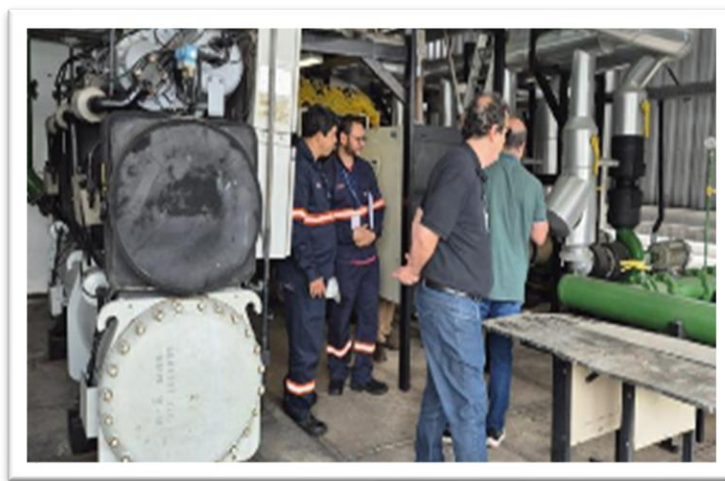
Visita técnica ao Fórum de Madureira, objetivando a melhoria dos indicadores de eficiência energética e hídrica.
