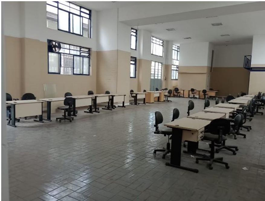
Espaço reformado em fase de acabamento.
