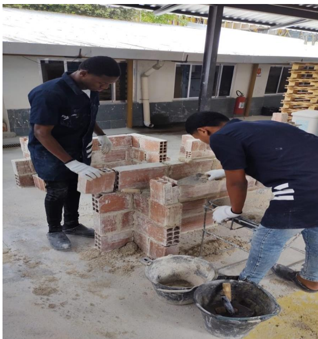
Aula prática curso de Pedreiro de Edificações no SENAI Niterói
